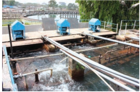
آکسیجن ملانا - پمپ کی مدد سے پانی میں ہوا داخل کی جاتی ہے جس کی وجہ سے ہوا کی آکسیجن پانی میں حل ہو جاتی ہے۔
